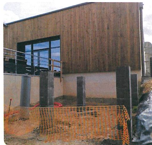
L'aménagement extérieur du restaurant continu, des piliers ont été installés pour accueillir prochainement une terrasse en bois.
