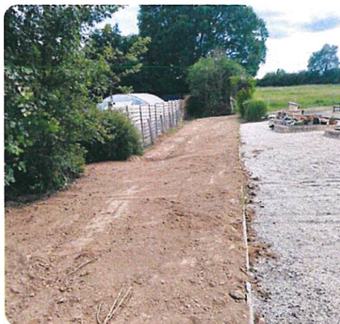
Au cimetière, un terrassement a été effectué.
